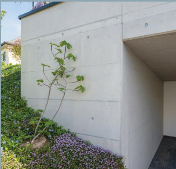
▲► Referenzbeispiel MFH Maiholz, Tiefgarageneinfahrt: schonende Reinigung mit Heisswasserhochdruckreiniger, Spezialreinigung von Kalkschleiern und Rostfahnen, Hydrophobierung und Sichtbetonlasur in einem feinen Grau.
