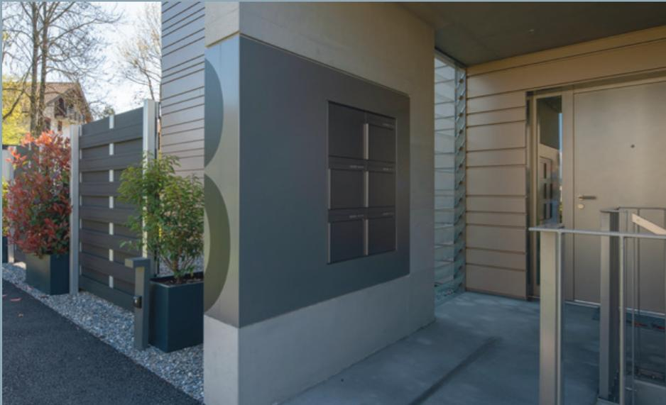
▲► Referenzbeispiel MFH Muri, Treppenhaus: schonende Reinigung mit Heisswasserhochdruckreiniger, Spezialreinigung von Kalkschleiern und Rostfahnen, Bindlochspachtelung und Betonkosmetik, Hydrophobierung und Sichtbetonlasur in einem feinen Grau.
