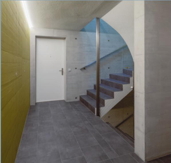
▲► Referenzbeispiel Treppenhaus MFH Birri: manuelle Reinigung von Ort beton, Betonkosmetik im Bereich von Lunkern, Kiesnestern, Schalungsübergängen und Sichtbetonlasur in feinen Grau- und Grüntönen.
